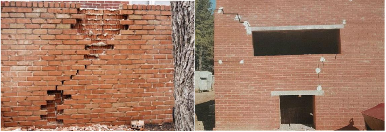
Рисунок 2. Расслоение кладки и выпадение отдельных камней, образование трещин.
