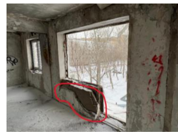
Рис. 6. Трещины по внутреннему слою штукатурного покрытия: а - стеновая панель в осях 9-10/В на отм. +2,700 (2 этаж); б - стеновая панель в осях 8-9/В на отм. +5,400 (3 этаж)
