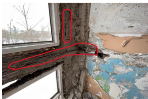
Рис. 7. Стеновая панель с разрушением газобетонного слоя: а – в осях 5–6/А на отм. +0,000 (1 этаж); б- в осях 16–17/А на отм. +10,800 (5 этаж); в – в осях 6–7/В на отм. +8,100 (4 этаж)
