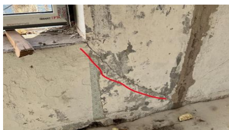
Рис. 6. Трещины по внутреннему слою штукатурного покрытия: а - стеновая панель в осях 9-10/В на отм. +2,700 (2 этаж); б - стеновая панель в осях 8-9/В на отм. +5,400 (3 этаж)
