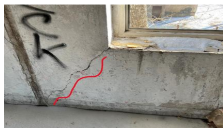
Рис. 6. Трещины по внутреннему слою штукатурного покрытия: а - стеновая панель в осях 9-10/В на отм. +2,700 (2 этаж); б - стеновая панель в осях 8-9/В на отм. +5,400 (3 этаж)
