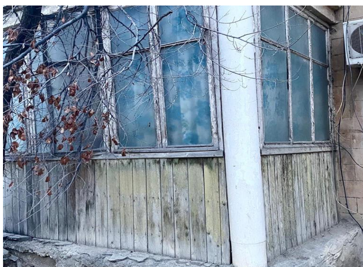
Сурет 3. Қоршау конструкциясында зеннің пайда болуы
