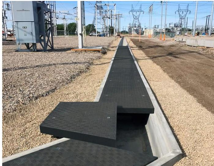
Рисунок 2.3 Дорога из композитных материалов
