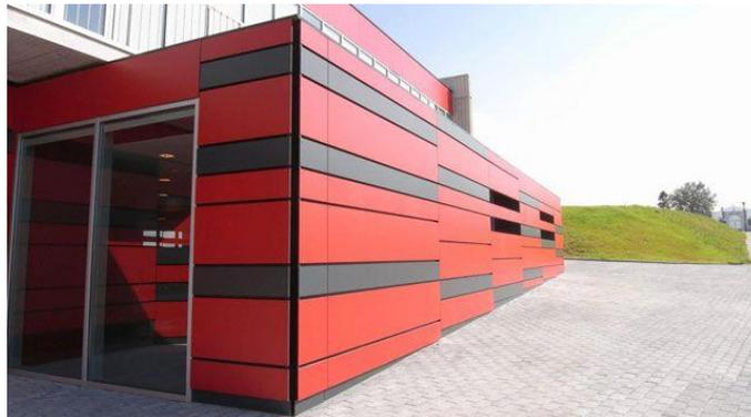
Рисунок 2.1 Фасад из композитных материалов
