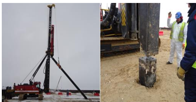
Рисунок 1. Установка сборной железобетонной сваи
