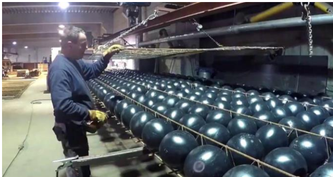
Рис. 4. Изготовление блока из вкладышей с арматурой.
