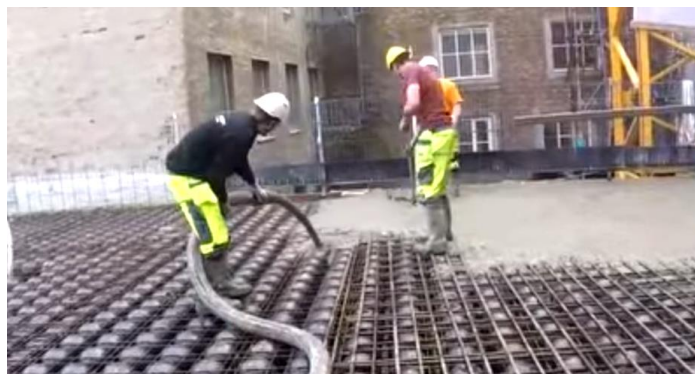
Рис. 6. Добетонирование верхнего слоя на строительной площадке.
