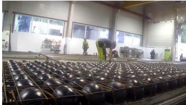
Рис. 5. Установка блока вкладышей в арматуре на нижний слой бетона.
