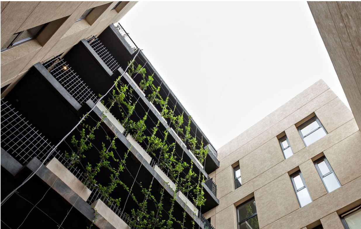
Рисунок 3. Фрагмент фасада PH Bamboo (Bamboo Studios). Буэнос-Айрес.
