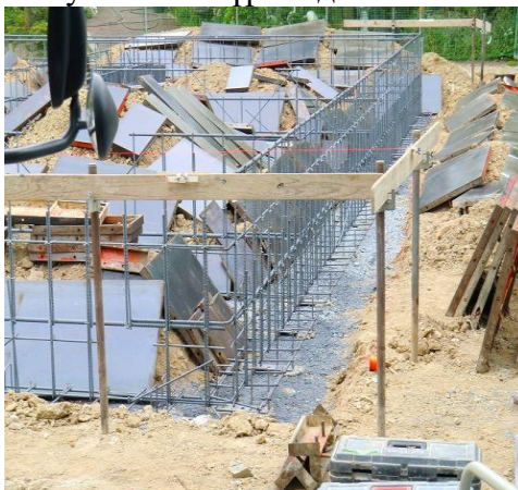
1-сурет. Ғимараттың іргетасы: темірбетонға арналған жинақтау торы.
