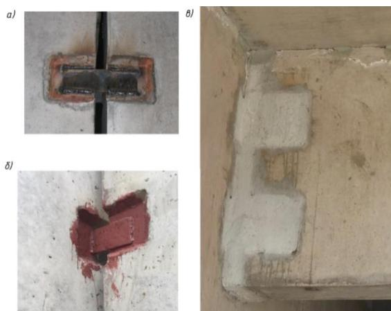
Рис. 2 Примеры вертикального сварного соединения стеновых панелей.
