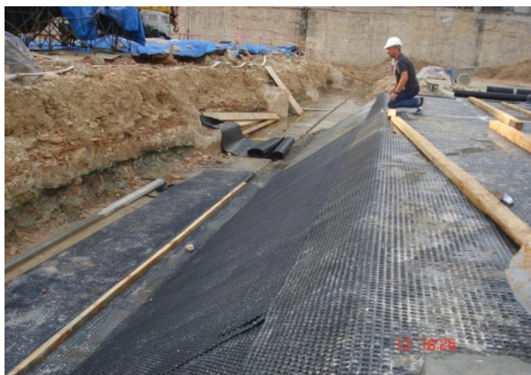
2. Профилированная мембрана
