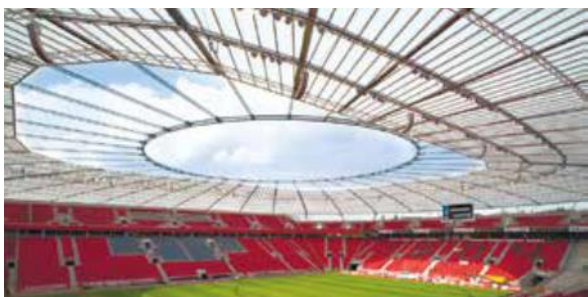
Сурет 5. Контур фермалары мен аспалы арқалықтар, BayArena, Лейпциг, Германия, сәулетші Макс Богл, BMR Structural Engineering, 2009.
