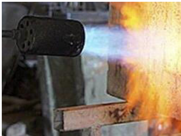
Рис.4 Огневая очистка
