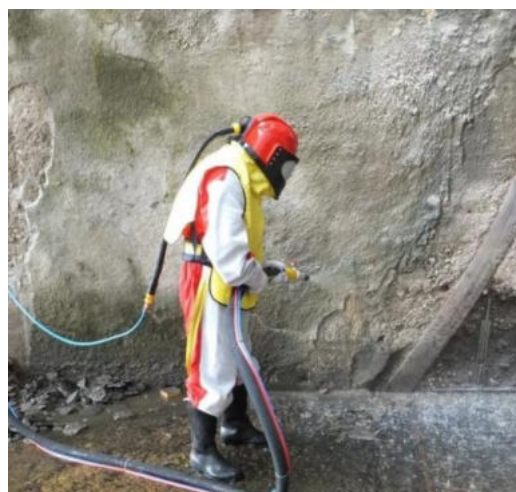
Рис.2 Пескоструйная очистка
