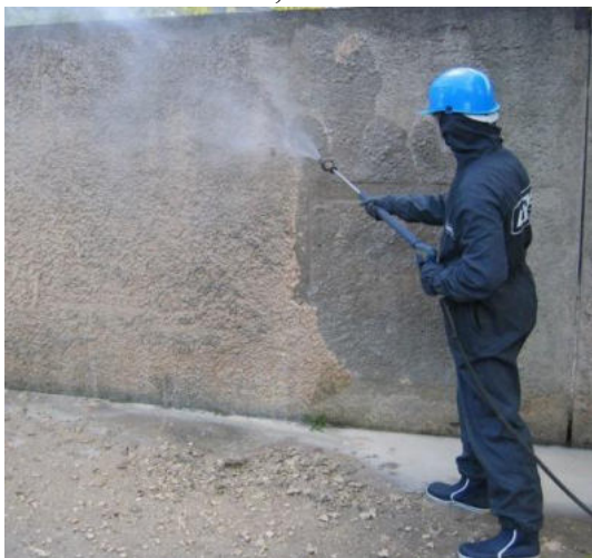
Рис.1 Гидрофрезеровочная очистка
